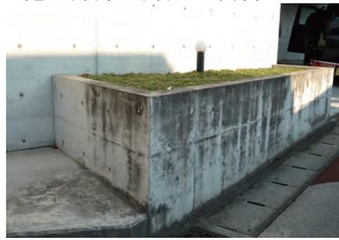
コンクリート油汚れ洗浄剤 A 1 を塗布し、低圧で洗浄
