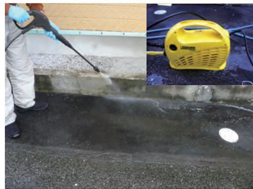
洗浄器でテスト洗浄後、ブロック塀にカビ取り洗浄剤を塗布し、低圧でパターンを広げ洗浄しました。
