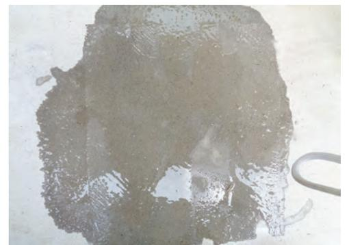
塗料を濡れたスコッチで擦り落とし、水をかけて洗い流す
