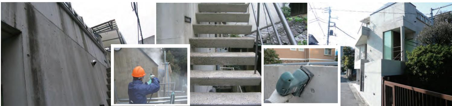
ベランダは大変な汚れ・床と手摺り基礎を高圧で洗浄・・・サンディング
