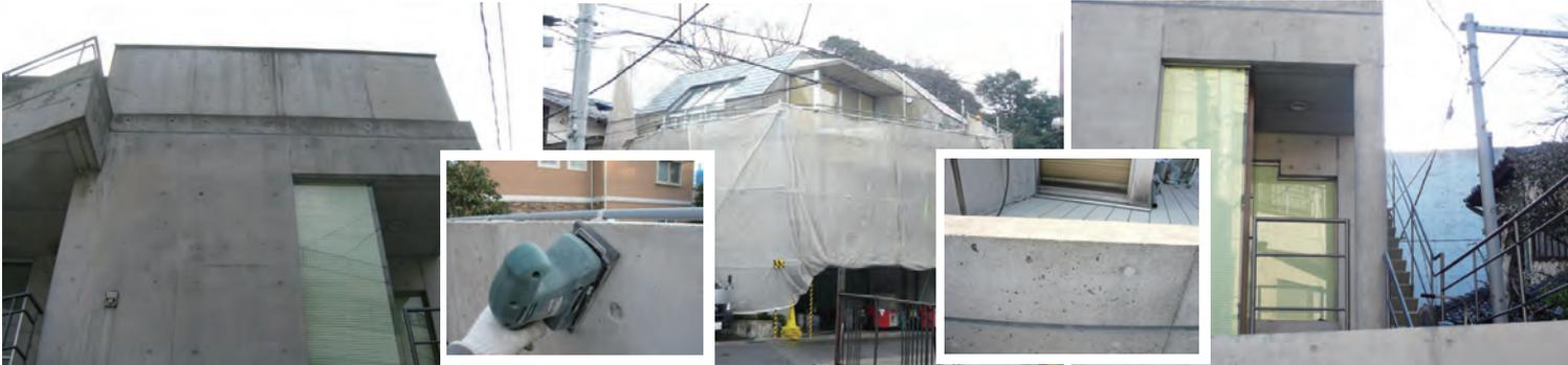
北の壁面の劇甚汚れ・・・高圧で洗浄・・・砂が飛び骨材肌の部分にサンディング
