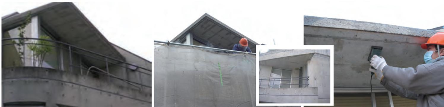
2Fの壁面の劇甚汚れ・・・高圧で洗浄・・・砂が飛び骨材肌の部分にサンディング
