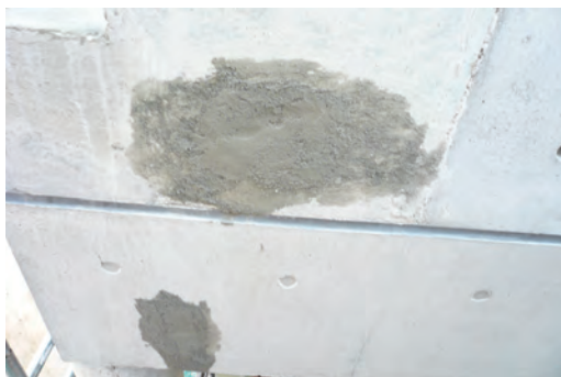
壁面の浮き出てきた鉄筋サビ
