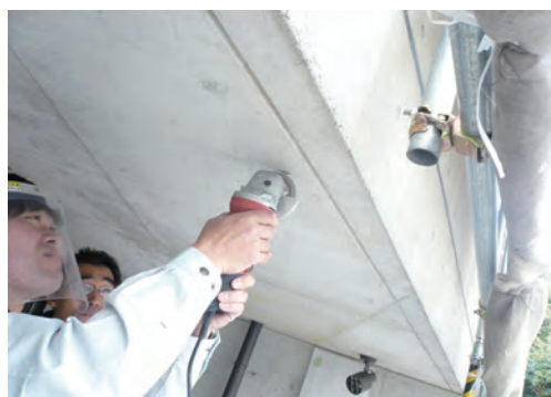
サンダーでコンクリート毎削り取る
