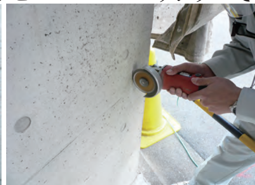
サンダーでコンクリート毎削り取る
