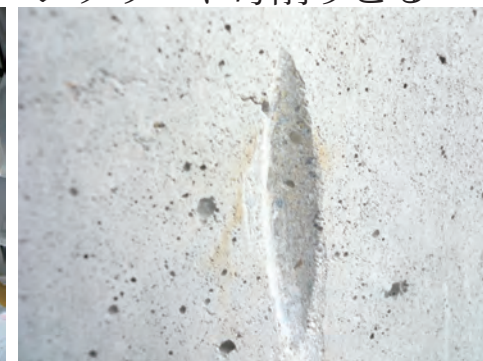
サンダーでコンクリート毎削り取る
