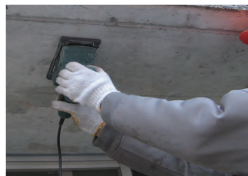
サンダーでコンクリート毎削り取る
