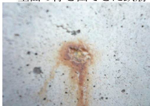
壁面の浮き出てきた鉄筋サビ
