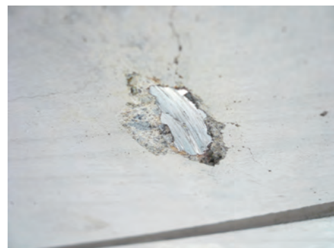
サンダーでコンクリート毎削り取る
