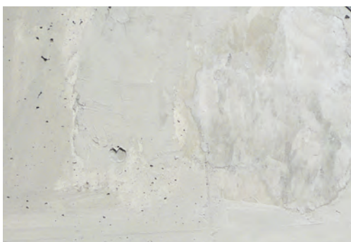
サンダーでコンクリート毎削り取る
