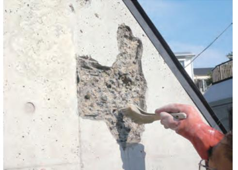
速乾モルタル（時には碎石ダストも混ぜる）で左官補修 サンディングで平滑補修
