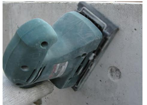
玄関ポールの劣化部分も削り取り、碎石ダストも混ぜ左官補修 サンディングで平滑補修
