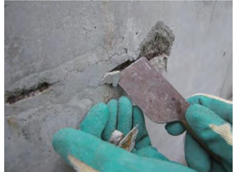
空洞部をハツリ、コンクリート内部を確認。コンクリートに受注生産品アルカリ注入剤を塗布
