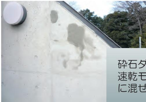
碎石ダストを速乾モルタルに混ぜ、充填。
