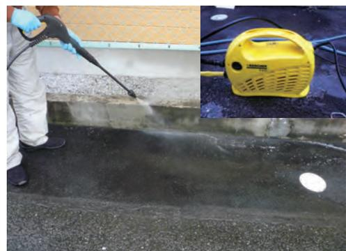
洗浄剤塗布後、洗浄器でテスト洗浄後、ブロック塀にカビ取り洗浄剤を塗布し、洗浄しました。
