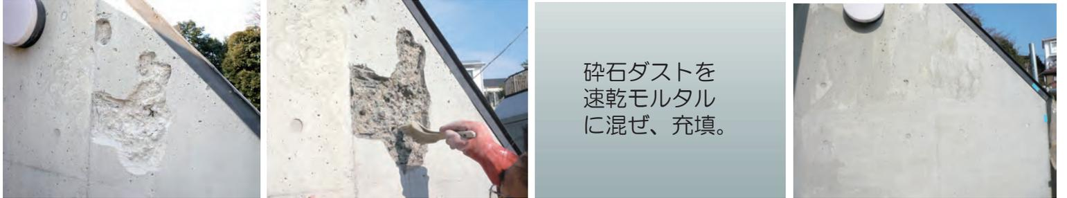
鉄筋の錆が浮き出たコンクリートをサンダーで削り取り、混合モルタルで左官仕上げをして、サンディング
