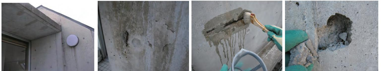
空洞部に碎石ダストとの混合モルタルを埋め、コンクリート面を仕上げサンディングをしました。
