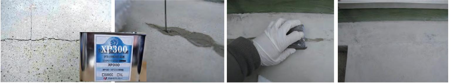
2F 東側ベランダ壁面の劣化部分の空洞部にアルカリ浸透材を注入し、空洞部をハツリました。
