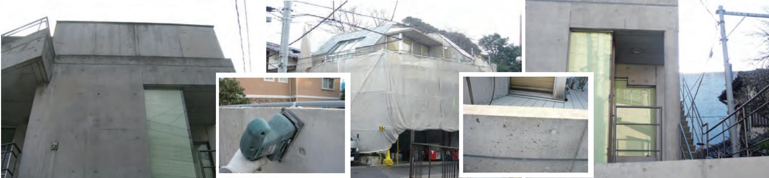
北の壁面は大変な汚れ・・・高圧で洗浄・・・砂が飛び骨材肌の部分にサンディング
