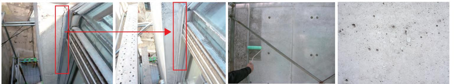
補修終了後、屋上・壁面全体にフェイスガード防水剤XP200を2回、塗布しシリコン防水層を作る
