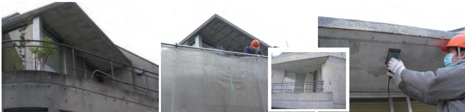
2Fの壁面は大変な汚れ・・・高圧で洗浄・・・砂が飛び骨材肌の部分にサンディング
