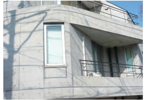
補修モルタル（時には碎石ダストも混ぜる）で左官補修
