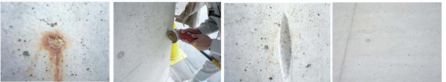
大きなひび割れにも混合モルタル埋込みXP300で補修
