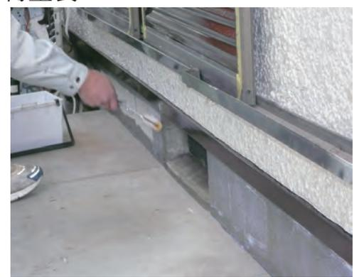
コンクリート内部のシリコンの防水層が雨水の浸透を防ぎます
