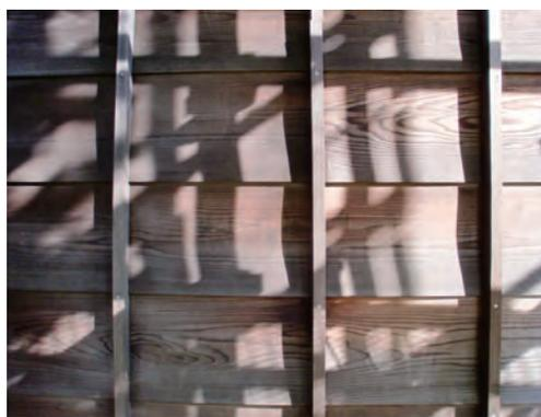
木部保護剤WG 2 シールドを噴霧。腐食で交換が必要な部分のみ新しい木部に塗装
