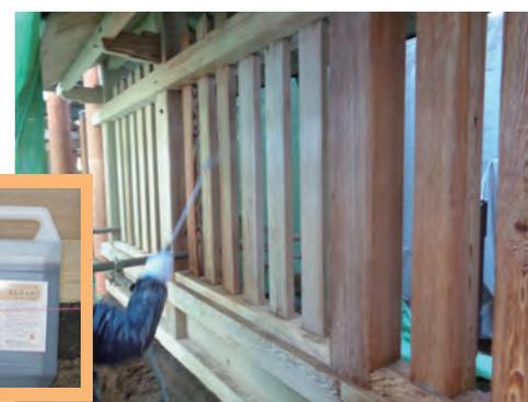
3：A3Re02で赤味を注入後、防カビ、日焼け抑制、防水の為に水性木部保護剤WG5を塗装
