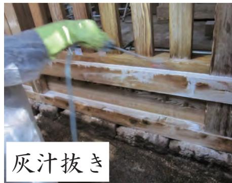
水洗い後、しみ抜き洗浄剤S4を塗布して水洗いを行う
