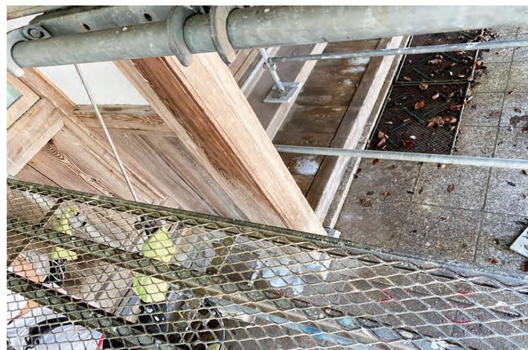
3：灰汁抜き洗浄後、シミ抜き洗浄を行いました。洗剤は木部シミ抜き用洗浄剤 S 4
