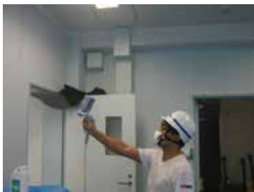
職員室へ吹付
