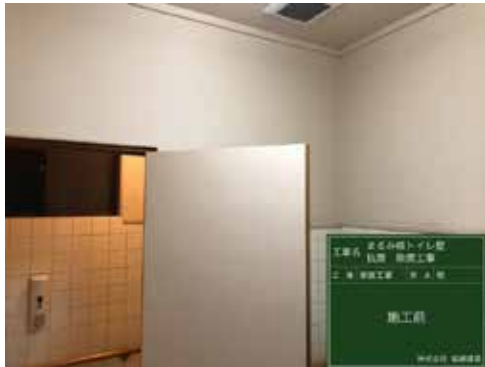
施工前のまるみ食堂トイレ
