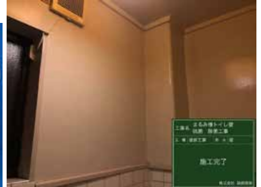
施工後のまるみ食堂トイレ
