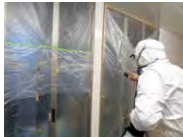
可視光反応型光触媒塗料 Faith guard-in.Attack を塗布
