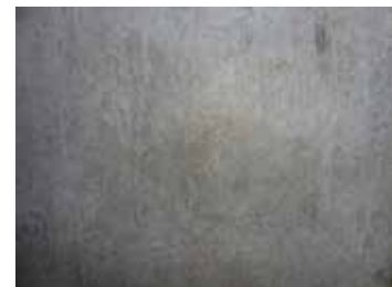
増量再塗装、翌日防水を確認 増量再塗装、翌日防水を確認
