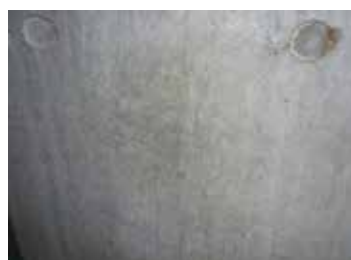
増量再塗装、翌日防水を確認 増量再塗装、翌日防水を確認
