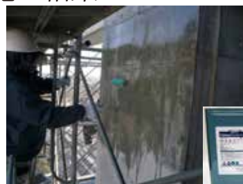
増量再塗装、翌日防水を確認 増量再塗装、翌日防水を確認
