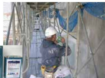
増量再塗装、翌日防水を確認 増量再塗装、翌日防水を確認
