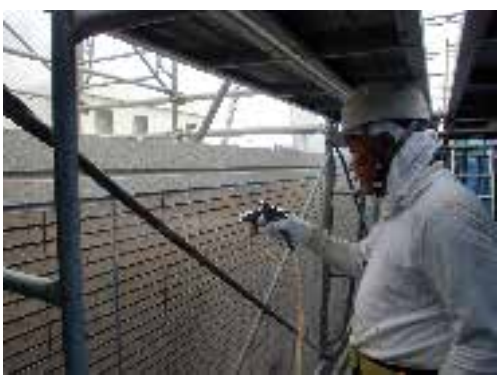
下塗剤塗布後 光触媒塗料Faith guard-out100Sを塗布
