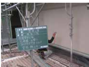
南面塗装面へ光触媒塗装（下塗り剤 B60、Faith guard out100S）
