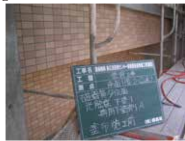
南面タイルへの光触媒塗装（下塗り剤 B60、Faith guard out100Sm）
