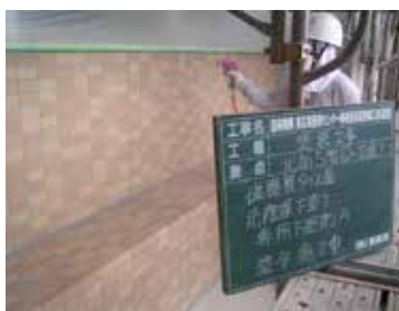
南面タイルへの光触媒塗装（下塗り剤 B60、Faith guard out100Sm）
