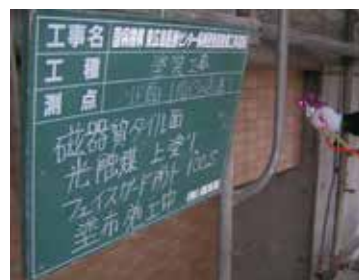
南面タイルへの光触媒塗装（下塗り剤 B60、Faith guard out100Sm）
