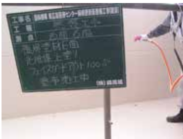
南面塗装面へ光触媒塗装（下塗り剤 B60、Faith guard out100S）
