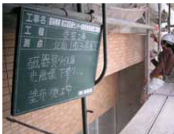
東面塗装面へ光触媒塗装（下塗り剤 B60、Faith guard out100S）
