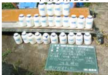
北面タイルへの光触媒塗装（下塗り剤 B60、Faith guard out100Sm）
