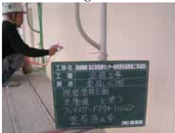
南面塗装面へ光触媒塗装（下塗り剤 B60、Faith guard out100S）
