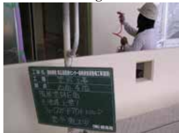
西面塗装面へ光触媒塗装（下塗り剤 B60、Faith guard out100S）
