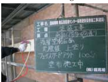
南面塗装面へ光触媒塗装（下塗り剤 B60、Faith guard out100S）
