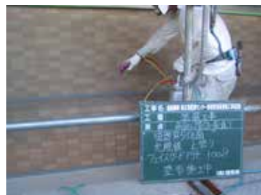
東面塗装面へ光触媒塗装（下塗り剤 B60、Faith guard out100S）
