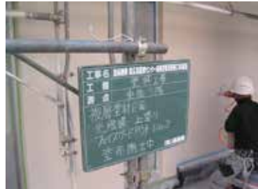
東面塗装面へ光触媒塗装（下塗り剤 B60、Faith guard out100S）
