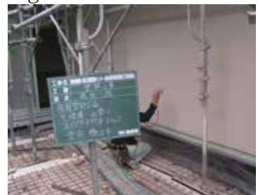
西面塗装面へ光触媒塗装（下塗り剤 B60、Faith guard out100S）
