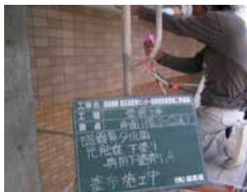
西面塗装面へ光触媒塗装（下塗り剤 B60、Faith guard out100S）
