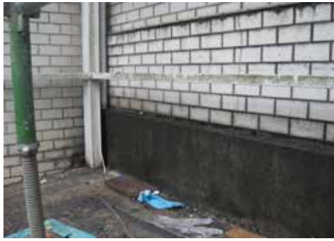
汚れた外壁タイルを高圧で汚れを除去。
