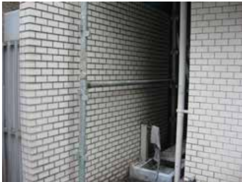
汚れた外壁タイルを高圧で汚れを除去。
