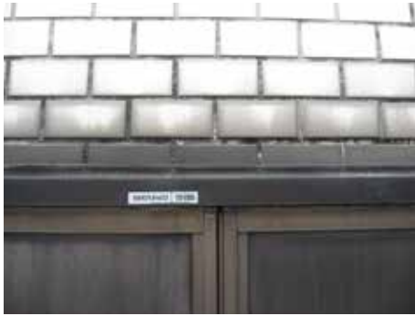
汚れた外壁タイルを高圧で汚れを除去。
