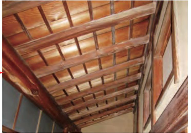
木部アク取り洗浄剤A3を塗布、濡れた雑巾で拭き取り後、木部シミ抜き洗浄剤S4で塗布して拭き取り
