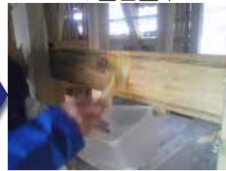
A4:B1 混合液を 2 倍希釈で塗布 1 回目塗布
