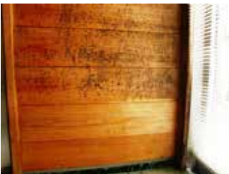
重度の木部のカビへの洗浄力の確認 A4:B1 混合液を 2 倍希釈で塗布
