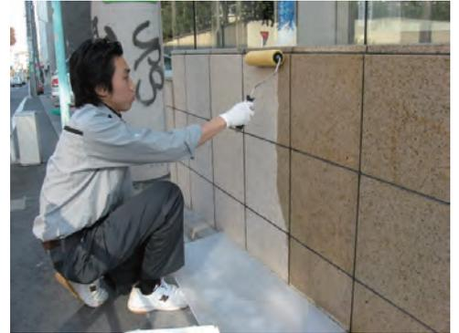
洗浄機を使わない場合、S2をローラーで塗布し、スコッチで擦り、水洗い。
