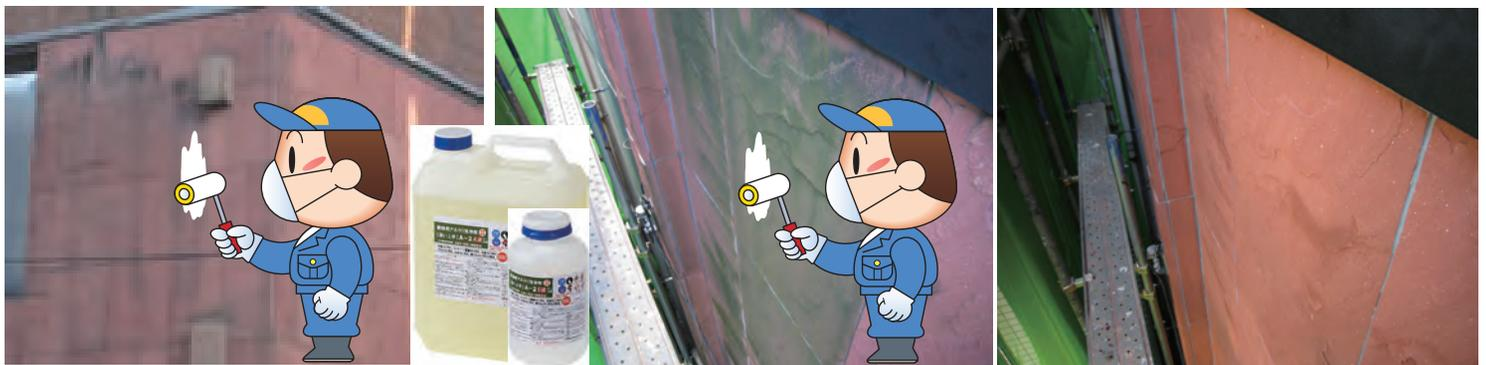
水性防水剤 Water Proof を2回塗布すれば、砂岩石内部にシリコン防水層が形成、防カビに。
