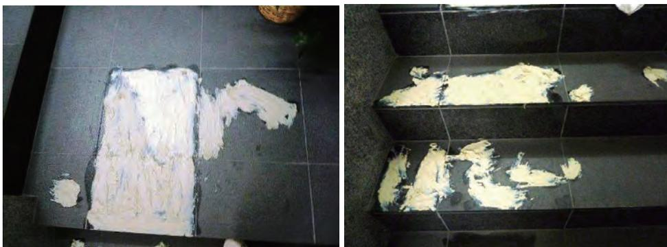
パック後、ビニールで養生し、油を 24 時間吸い上げ、アルカリスーパー A7 を塗布して、スコッチ擦り洗い
