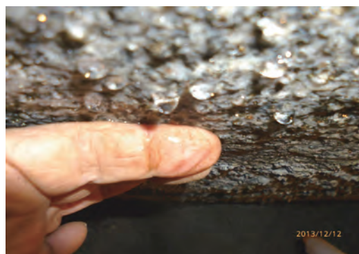
水性防水剤 Water Proofを塗布 面は防水状態で水滴で水滴が垂れます
