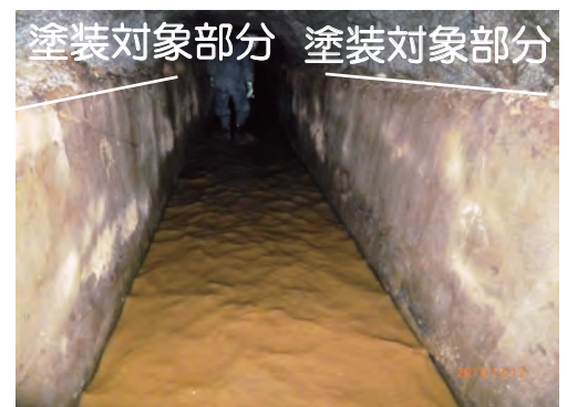
水性防水剤 Water Proofを塗布 面は防水状態で水滴で水滴が垂れます
