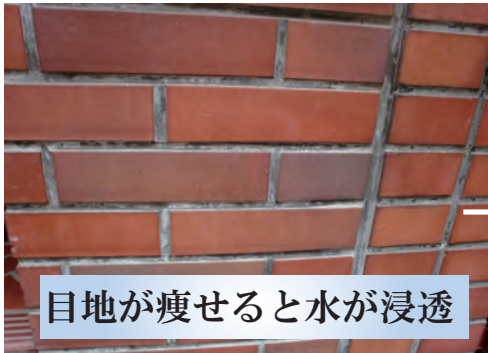
目地から水が浸透、水に溶けたカルシウム Ca が上に上がる
