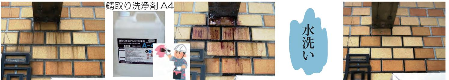
タイルの錆に A4 を塗布すると錆は水溶化し紫色に変わります。水溶化した紫色の錆は水洗いで洗い流します。
