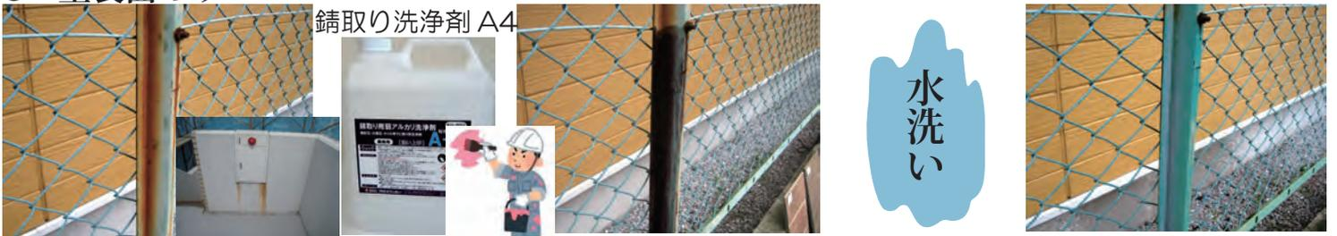
塗装面の錆に A4 を塗布すると錆は水溶化し紫色に変わります。水溶化した紫色の錆は水洗いで洗い流します。
