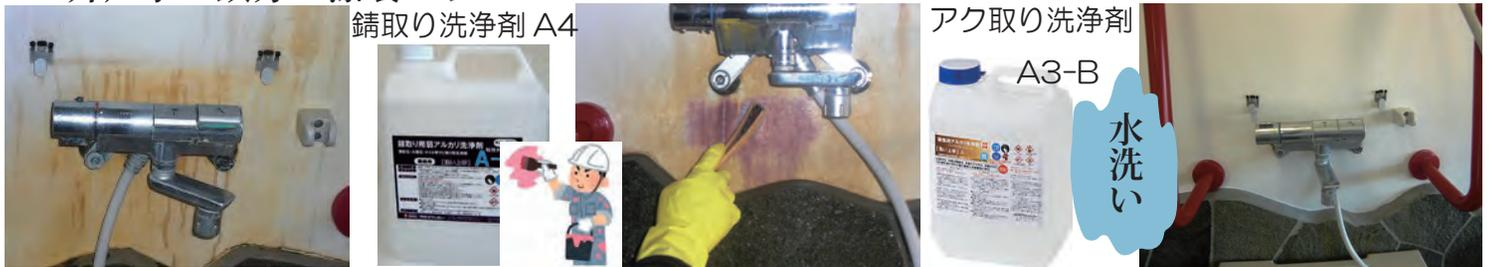
漆喰の錆に A4 を塗布すると錆は水溶化し紫色に変わります。次に A3-B を塗布すると透明になり、水洗いで終了。
