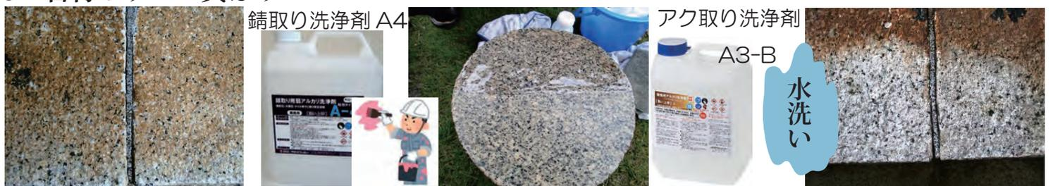
石材の錆に A4 を塗布すると錆は水溶化し紫色に変わります。次に A3-B を塗布すると透明になり、水洗いで終了。
