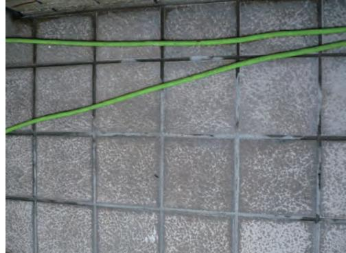
エフロ・錆取り洗浄剤S5を塗布して、スケールと一体化した汚れをスコッチで擦り落し汚れを拭き取り乍、除去し、水洗いをして、劇甚汚れを除去しました。
