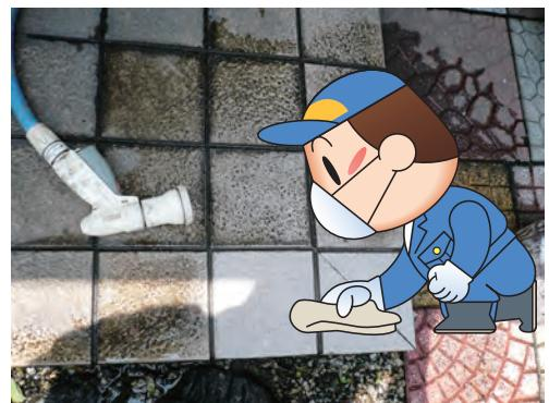
最強の酸性洗剤：エフロ・錆取り洗浄剤S5でスケールと一体化した汚れをスコッチで除去して水洗い後、タイル表面は荒れ、タールガードF塗装が必要になりました
