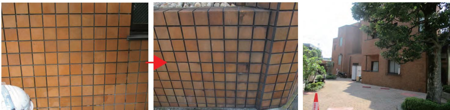
せつ器質タイルは撥水性がなく、汚れやすいタイルで、**タイル用洗浄剤S3**で落ちない**エフロ**は、その部分だけ**エフロ錆取り洗浄剤S5**を利用
