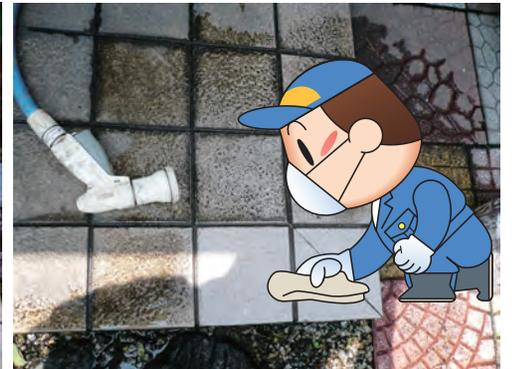
最強の酸性洗剤：エフロ・錆取り洗浄剤S5でスケールと一体化した汚れをスコッチで除去して水洗い後、タイル表面は荒れ、タイルガードF塗装が必要になりました
