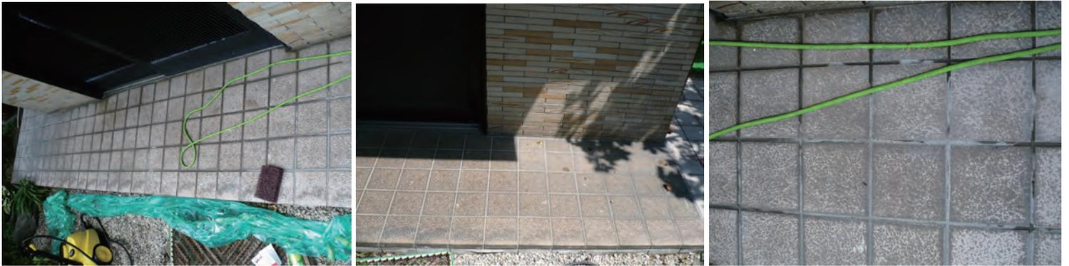
エフロ・錆取り洗浄剤S5を塗布して、スケールと一体化した汚れをスコッチで擦り落とし汚れを拭き取り乍、除去し、水洗いをして、劇甚汚れを除去しました。
