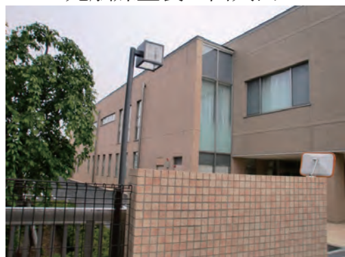
光触媒塗装正面入口
