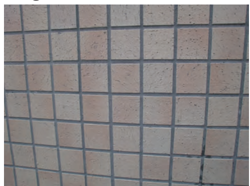
下塗剤塗布後 光触媒塗料Faith guard-out100Sを塗布
