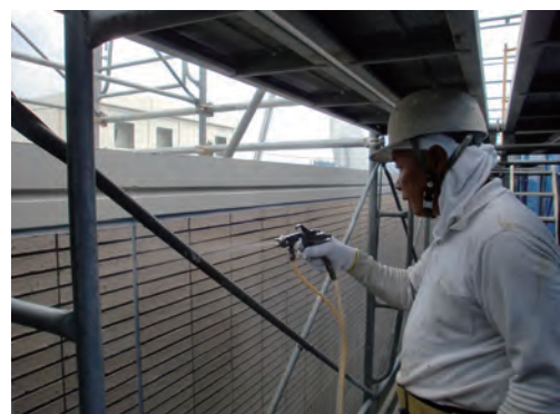
下塗剤塗布後 光触媒塗料Faith guard-out100Sを塗布
