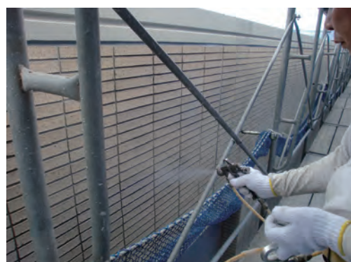
下塗剤塗布後 光触媒塗料Faith guard-out100Sを塗布
