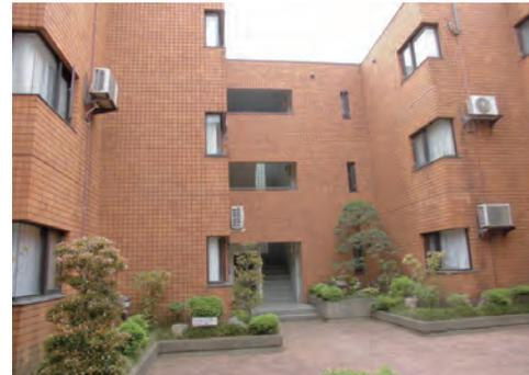
東日暮里側マンション改修で、目地も痩せ、漏水もあり、Water Proof-C を塗布。漏水は無し
