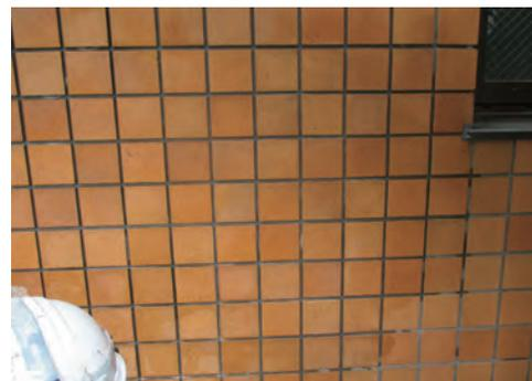
漏水が発生する壁面に増量塗布し、タイルと目地の防水を確認。漏水は以降ナシとの事
