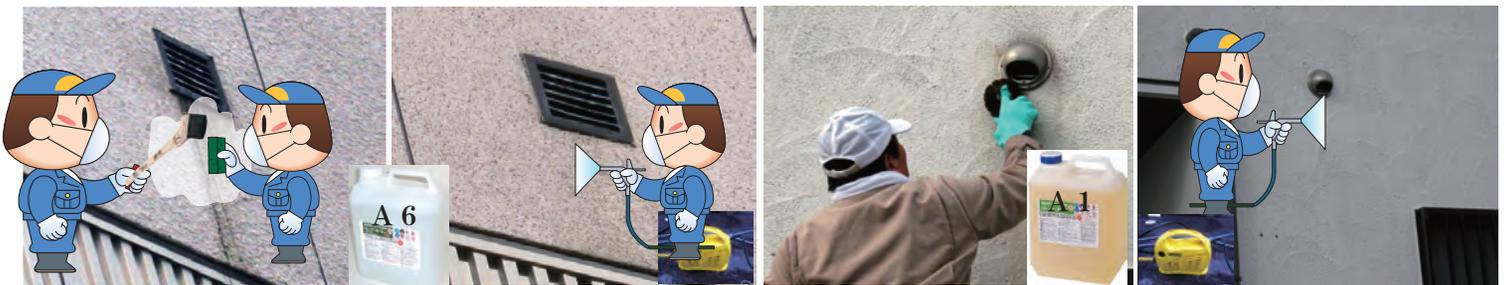
車両排気の油汚れはオイルリムーバー A 9 を塗布。水をかけながら擦り落とす。油は乳化して流れます
