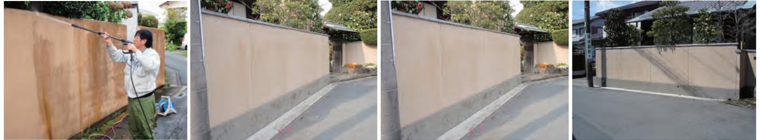
ジョリパットの排気口に附着した汚れは、コンクリート油汚れ洗浄剤 A 1 を塗布し、家庭用洗浄器で水洗い
