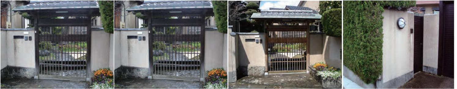
リシンの煤煙汚れはコンクリート油汚れ洗浄剤 A 1 の 2 倍希釈を塗布し、家庭用洗浄器で
