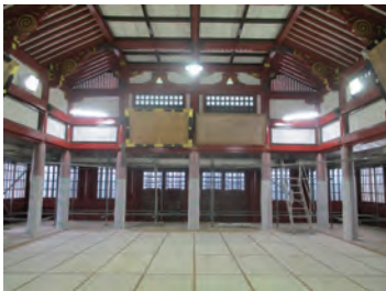
2017年6月第1期工事の剥離状況(塗膜を柔らかくしてめくる剥離です)
