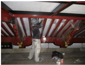
剥離後漆喰施工
