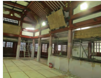
2017年6月第1期工事の剥離状況(塗膜を柔らかくしてめくる剥離です)
