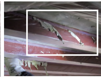
剥離後漆喰施工：テスト施工部分
