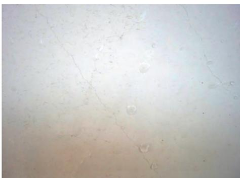
下塗剤 B60 を塗布して目止め 水性かび封じを塗布
