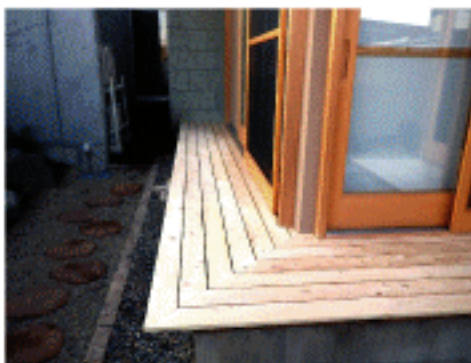
5分後ナイロンタワシで擦り水洗い。着色塗装をしない場合、木部シミ抜き用洗浄剤S4を塗布してください
