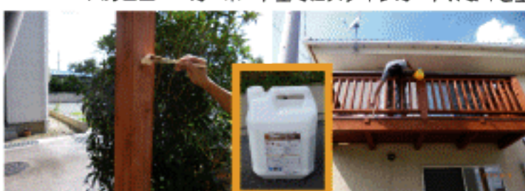
バルコニー・カーポート全てにステインガードWG4を塗布
