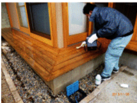
剥離スーパーA8を塗布
