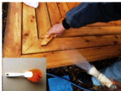
5分後ナイロンタワシで擦り水洗い。着色塗装をしない場合、木部シミ抜き用洗浄剤S4を塗布してください
