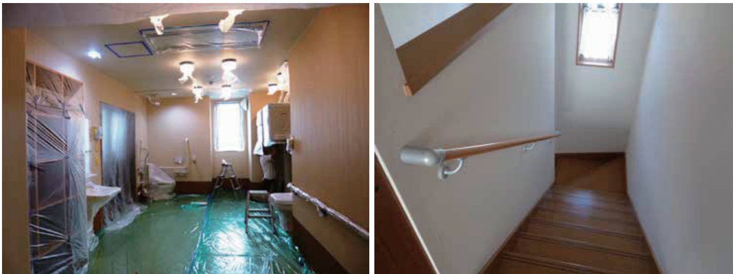
介護事業所の浴室・脱衣所・壁面のクロス・塗装面に 壁面のクロスで手が触れる部分に、手摺りにはアタック2
