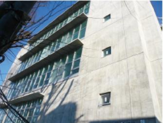
コンクリートへの吸い込みは全て異なる為、防水確認が不十分ですと光触媒を塗布しても天端が雨水にたたかれ、汚水が浸透し4~5年でコンクリートは汚れる場合があります。
