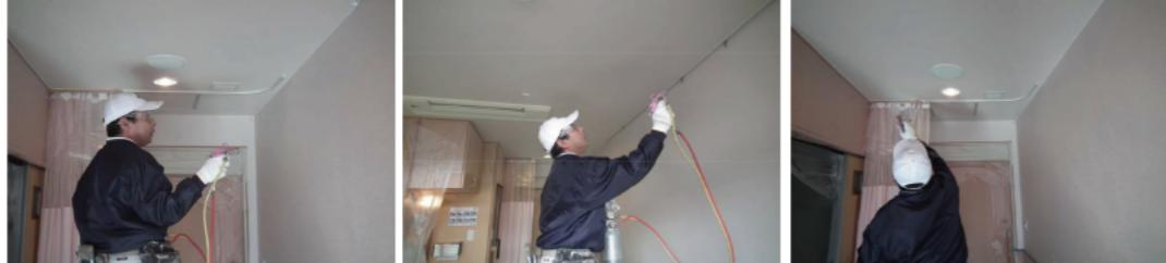
1ヶ月後、施工部の生物汚染菌数を測定しました。菌数は108を表示。石鹼で手を3回洗った菌数の抗菌状態に。
