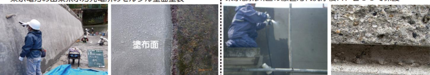
Water Peroof-CとXP200はレンガに浸透し、白華を防ぎ水の浸透による凍結融解を防ぎ、防カビ機能を発揮します
