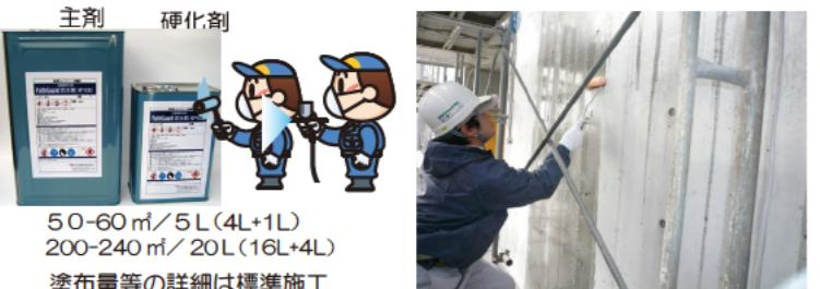
水の浸透具合を事前に確認、共通防水下塗剤 XP100 を十分塗布し、乾燥後、防水状態を確認。
