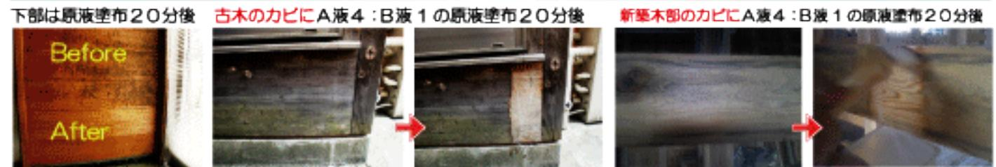
アクとカビの洗浄はカビ取り用 A2 を塗布し、洗浄せず直ちにアク取り用 A3 の連続洗浄で
