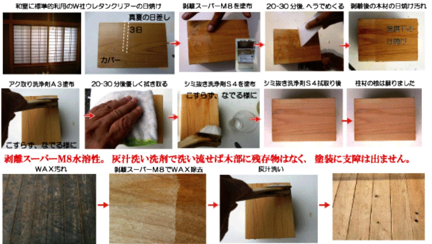
**剥離スーパーM8水溶性。** 灰汁洗い洗剤で洗い流せば木部に残存物はなく、塗装に支障は出ません。
