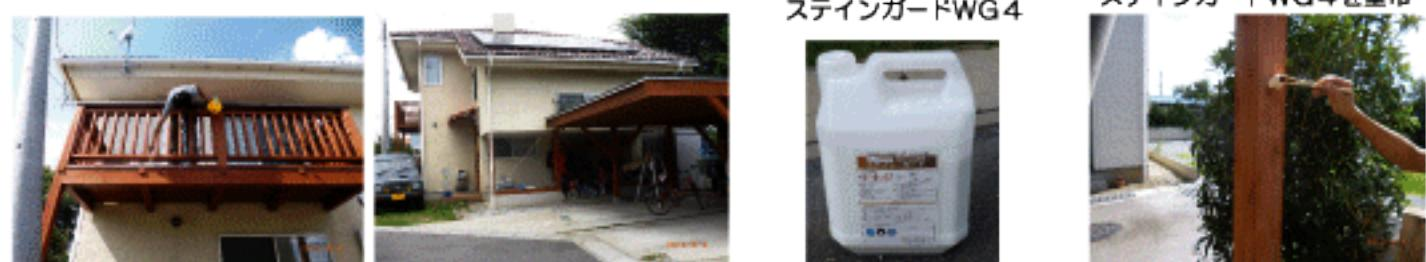
雨水で劣化したオイルステインを剥離、着色塗装後、ステインガードWG4保護塗装で強化
