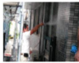
真夏はタイル表面が焼けて洗浄剤を塗布すると、すぐ乾燥し、タイル変色が起こります。水養生を先に行いタイルを冷やしてから洗浄剤を塗布して下さい。
