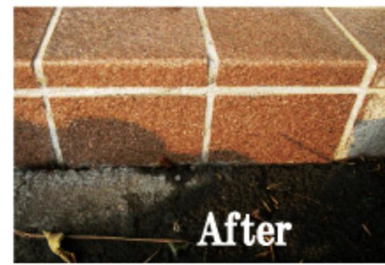
※エフロ洗浄の注意・エフロを洗浄し、水洗いが不足し表面にカルシウムが残り、乾燥して再結晶します。十分な水洗いを
