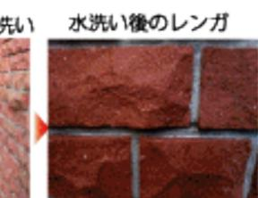
白華はS5で溶けます。水洗いを十分に流さないと、洗いが蒸発し、カルシウムが再結晶し白華になります。十分な水洗いを
