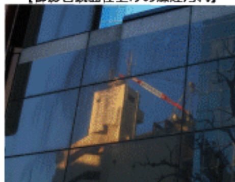
【御影石鏡面仕上げの煤煙汚れ】
