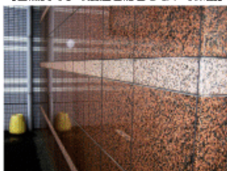
【自然美で水の浸透を防ぎSG1で保護】
