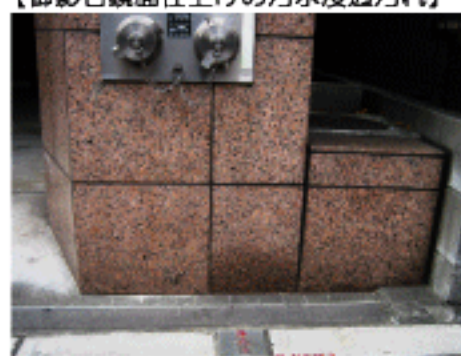
【御影石鏡面仕上げの汚水浸透汚れ】
