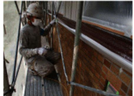
目地とタイルへの水の浸透を防ぎます
