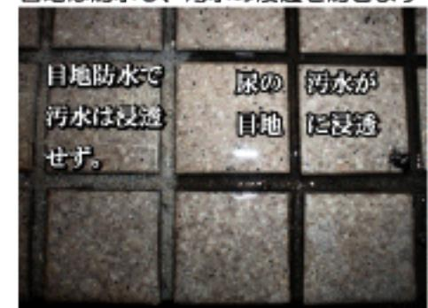
\* 吸い込みの少ないタイルへの施工は原則として1回 壁面・床面に Water Proof が残る場合 拭取る
